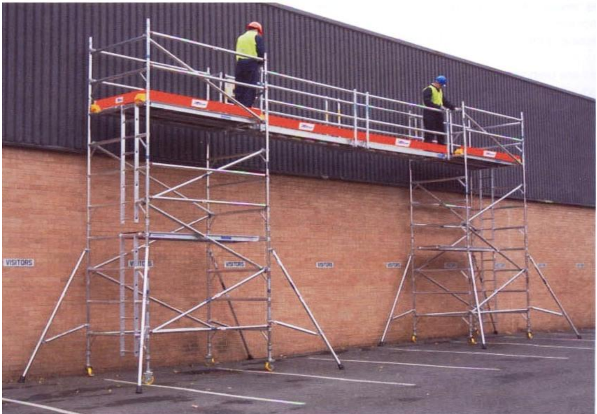
شکل ۲-۸ سکوهای کاری، داربست های برجی و واحدهای پل دار
